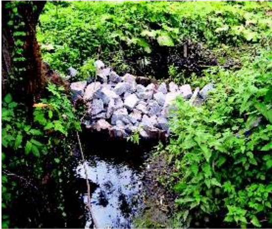
Kőből készült fenékküszöb (III típus)
